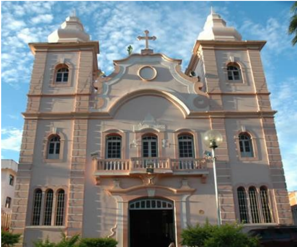
Figura 4: Igreja Matriz de Nossa Senhora da Conceição e São José após reforma/descaracterização. [Foto: MARÇAL, 2014].
