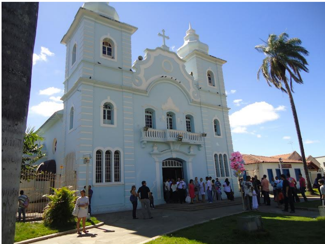
Figura 5: Igreja Matriz de Nossa Senhora da Conceição e São José após reforma de recaracterização. [Foto: ESPINOSA, 2012].
